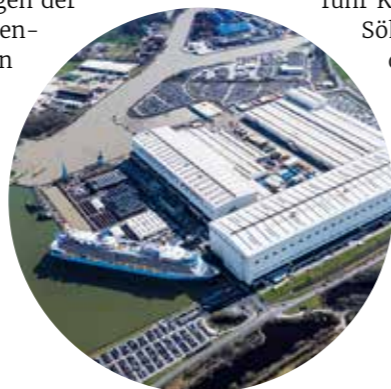
BLICK VON OBEN: Das Werftgelände am Südufer der Ems.
