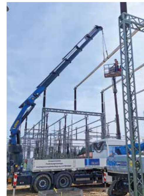
INSTALLATION: Ein SEAR-Monteur im Einsatz.
