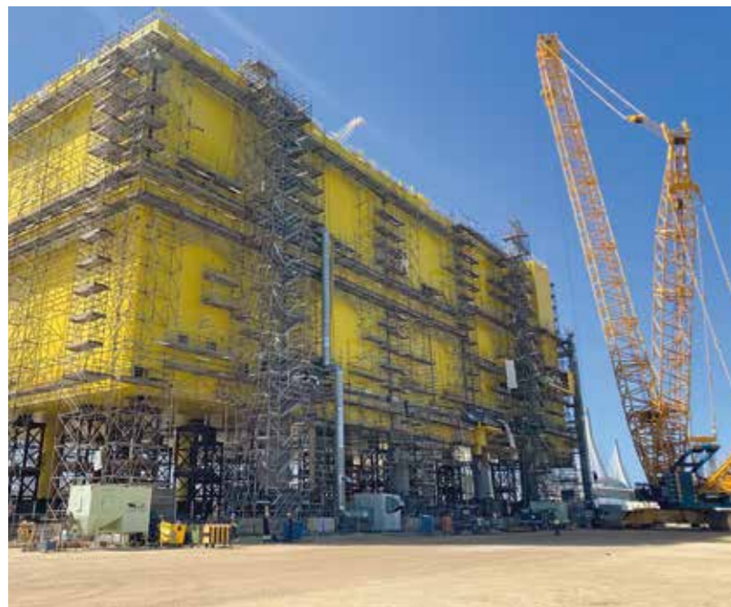
BEEINDRUCKENDE KONSTRUKTION: Die Umspannplattformen für Offshore-Windparks werden an Land gebaut und danach aufs Meer gebracht.
